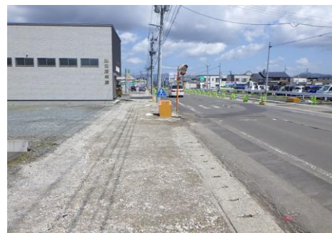
電線共同溝本体工事(完了後) ※歩道部舗装の美装化及び抜柱は次年度以降に施工予定
