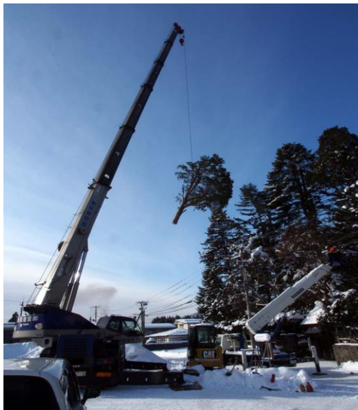
大型クレーン吊による伐採作業状況
