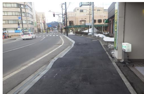
電線共同溝本体工事(完了後) ※歩道部舗装の美装化及び抜柱は 次年度以降に施工予定
