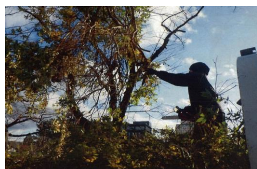
北側斜面の刈払い作業
