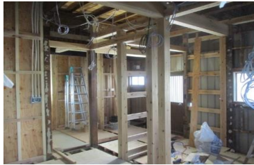
新設補強柱梁組
