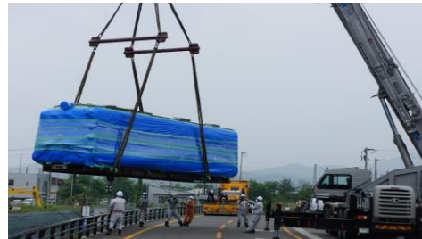
秋田犬の里に到着し、クレーン吊で設置(令和2年8月6日)
