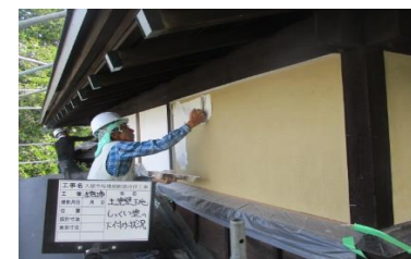
外壁漆喰壁仕上げ
