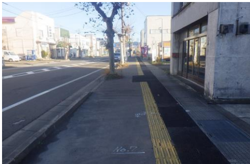
電線共同溝本体工事(着手前)
