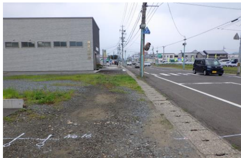
電線共同溝本体工事(着手前)
