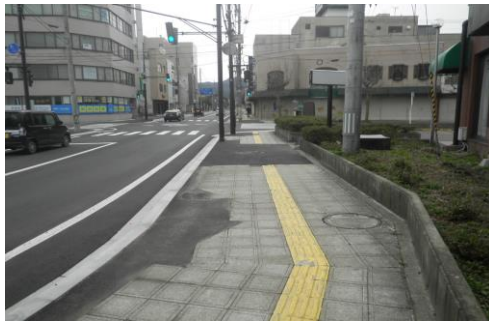
電線共同溝本体工事(着手前)
