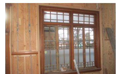
耐震金物取付
