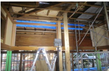
大広間鉄骨梁補強
