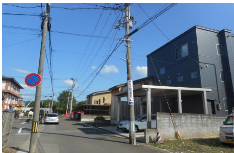
電柱統合移設前(道路両側に建柱)
