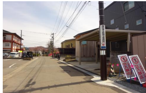
電柱統合及び景観色鋼管柱を建柱
